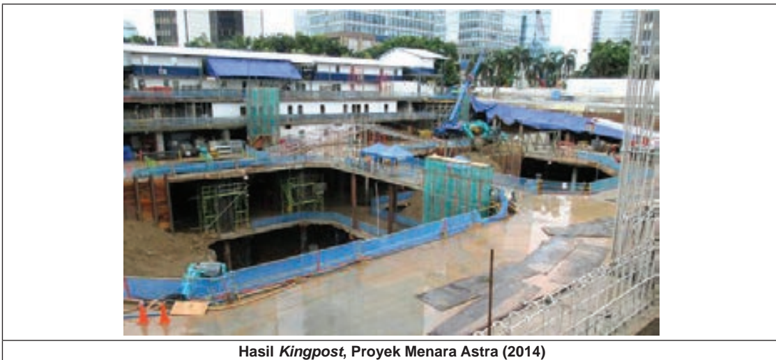
Hasil Kingpost , Proyek Menara Astra (2014)
