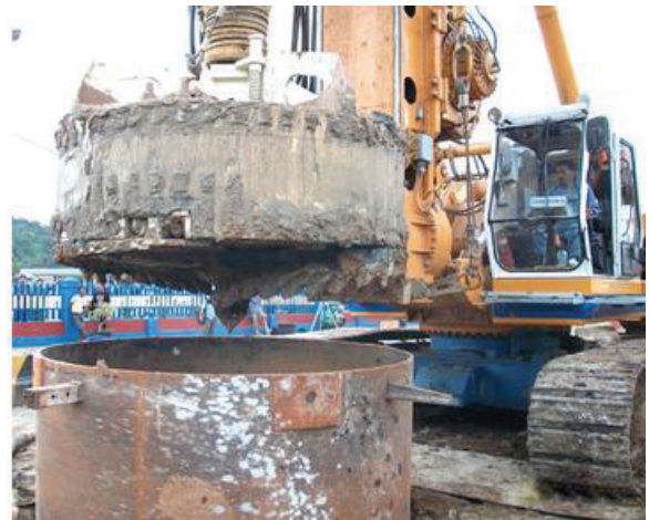
Bor dengan bucket auger
