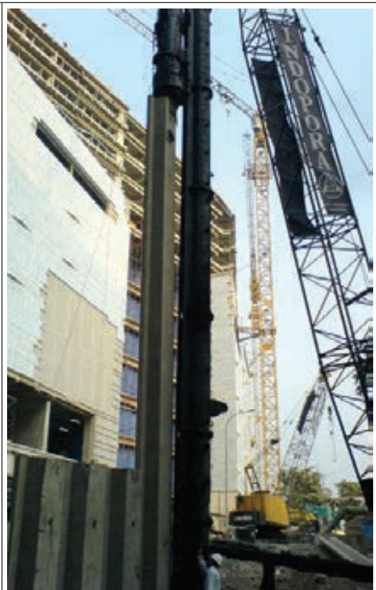
Pemasangan Corrugated Sheet Pile dengan Diesel Hammer
