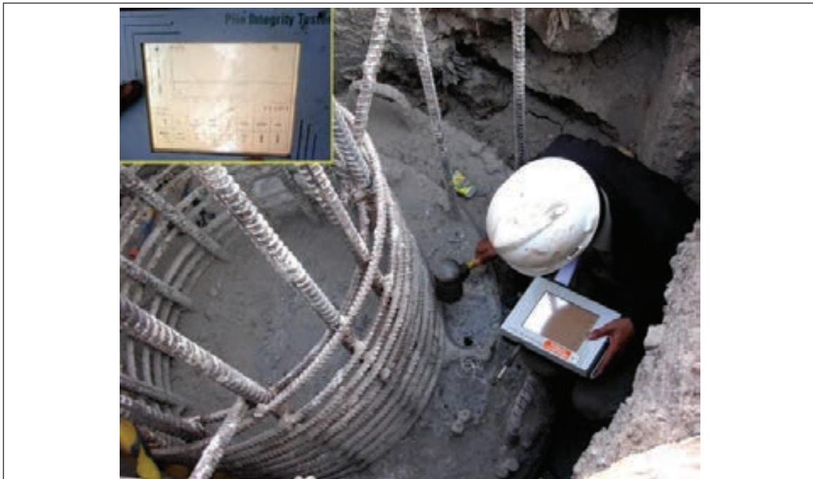
PIT Tes Proyek Flyover Merak (2010)
