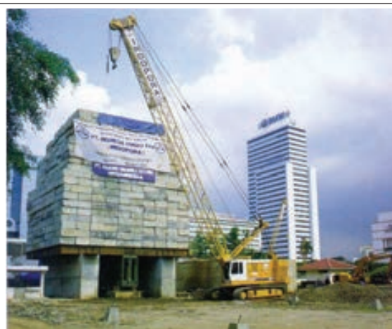
Tes tekan 3.300 ton Proyek Plaza Indonesia Extention (1997)
