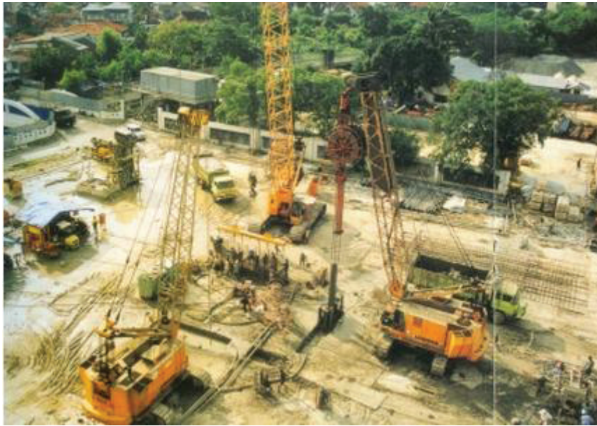
Barrette Pile Proyek Plaza Indonesia (1997)
