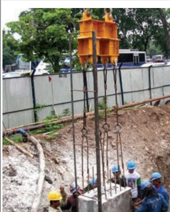
Pemasangan Beton Pracetak
