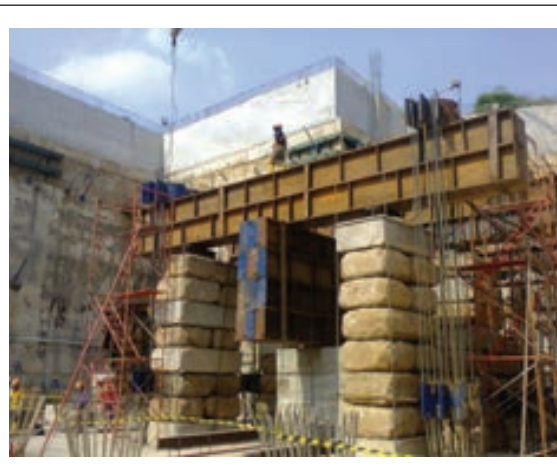
Tes tekan reaksi 2.100 ton Proyek GTU Simatupang (2014)
