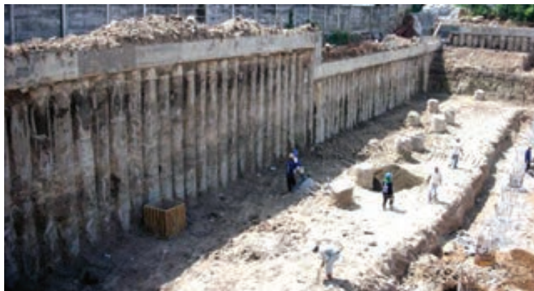
Secant Piles , Proyek St. Moritz - Puri Kembangan (2008)
