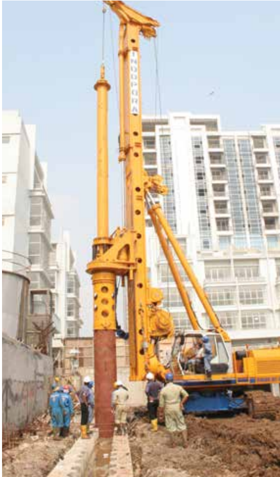
Guidewall untuk Soldier, Contiguous, dan Secant Piles
