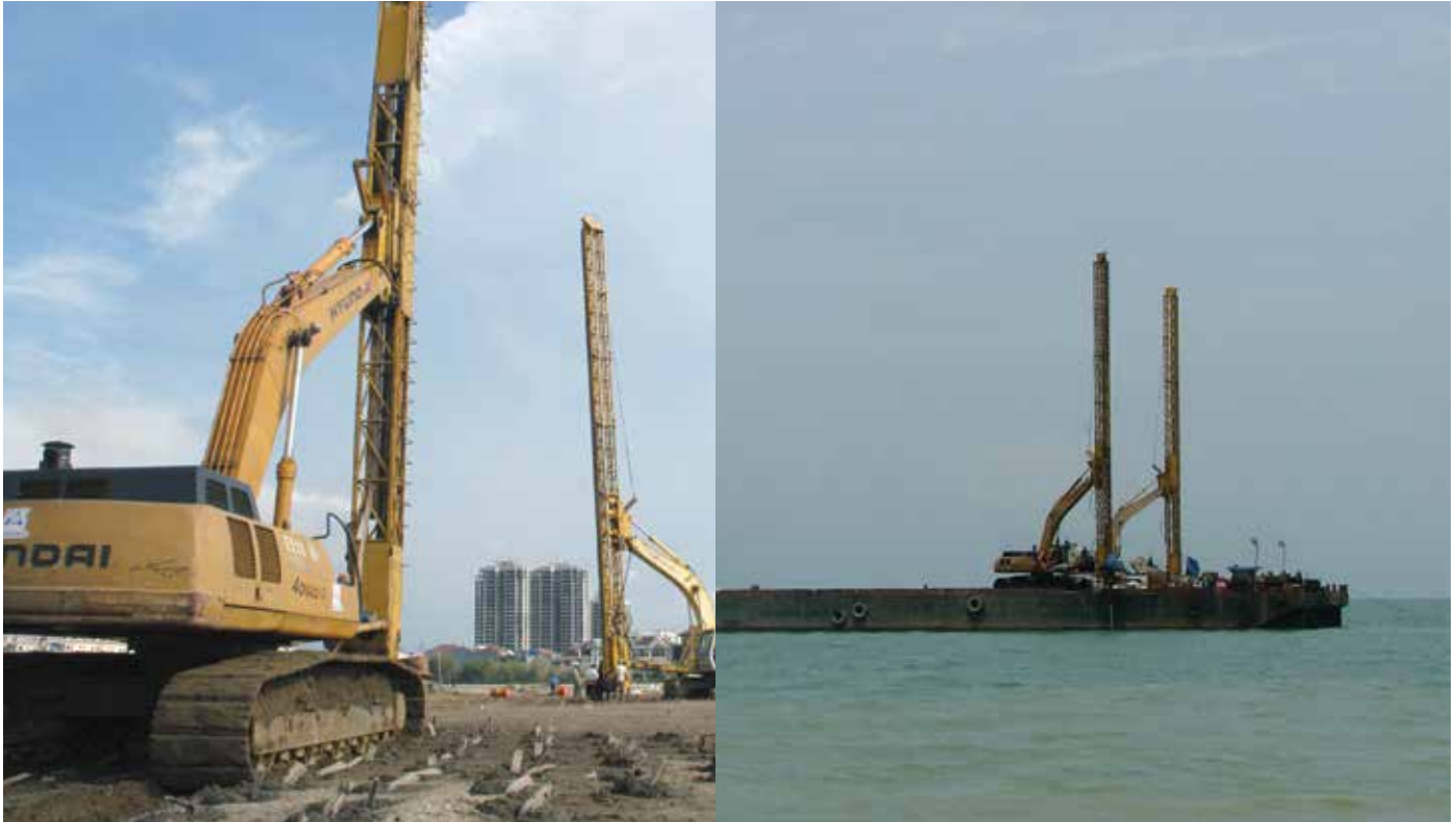
Pemasangan Vertical Drain
