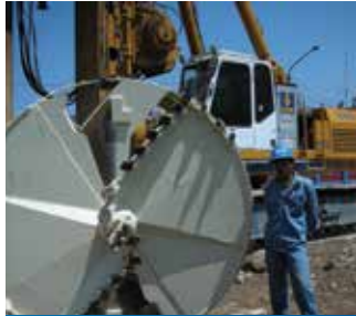
Bor diameter 2,5 meter Flyover - Merak, Banten
