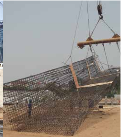
Pembesian DWall bentuk L
