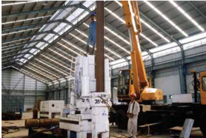
Pemasangan Steel Sheet Piles dengan Silent Piler
