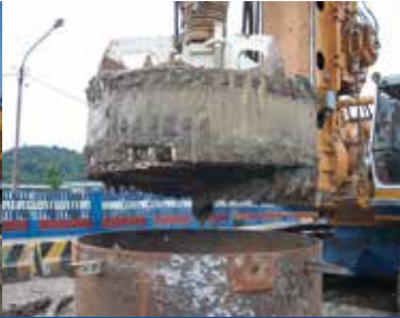
Bor diameter 2,5 meter Flyover - Merak, Banten
