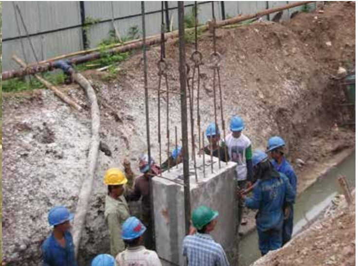
Material dan Pemasangan DWall Pracetak
