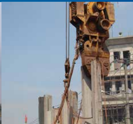
Pemasangan Concrete Sheet Pile dengan Vibro Hammer
