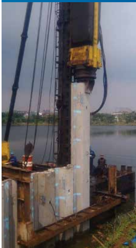
Pemasangan Concrete Sheet Pile dengan Hydraulic Hammer
